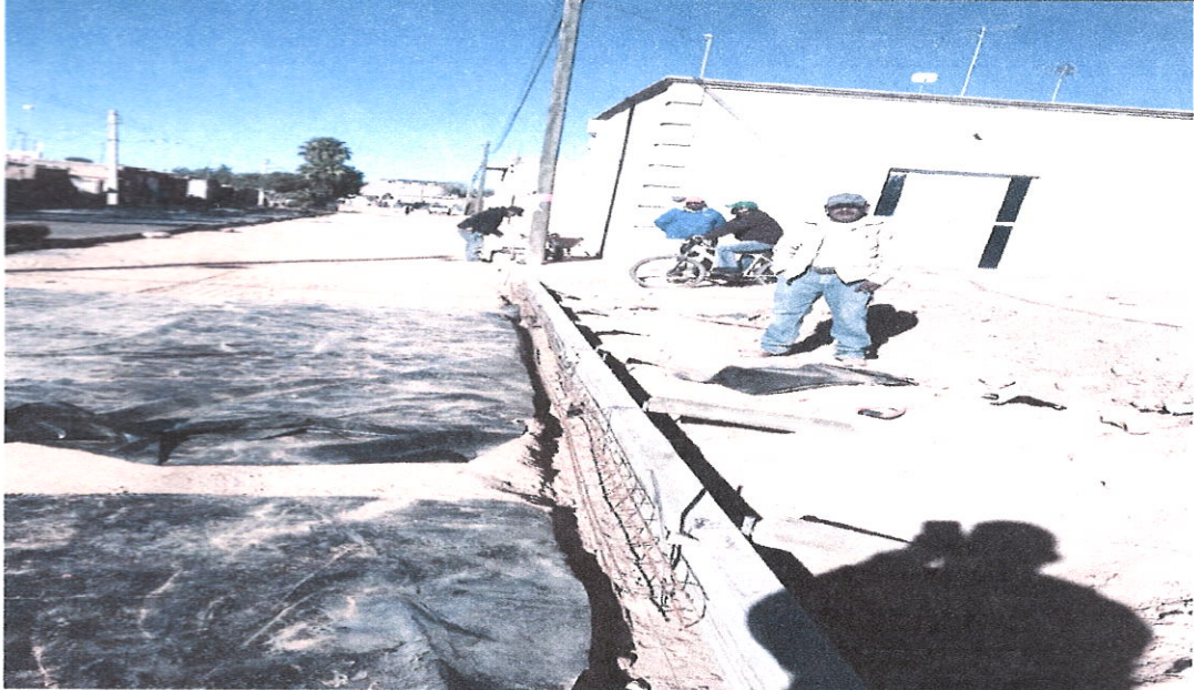
9 CONSTRUCCION DE DENTELLON COMO ELEMENTO ESTRUCTURAL PARA RECIBIR LAS CARGAS CONCRETO F'C=200 KG/CM2, ARMADO CON ARMEX DE 30X15 CMS
