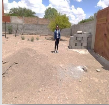
Apoyo de Material de Construcción al Prescolar de la comunidad de Ignacio Zaragoza (San Diego).
